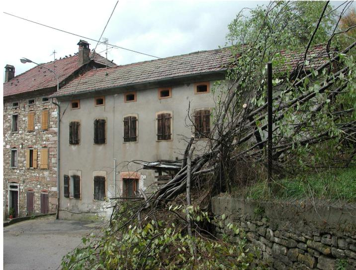
**Figura 7 - Colata di terra rapida in appoggio ad una abitazione - Farra d'Alpago**
